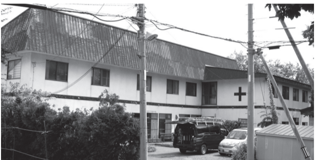
ホーム「青十字サマリヤ館」が建てられた。
